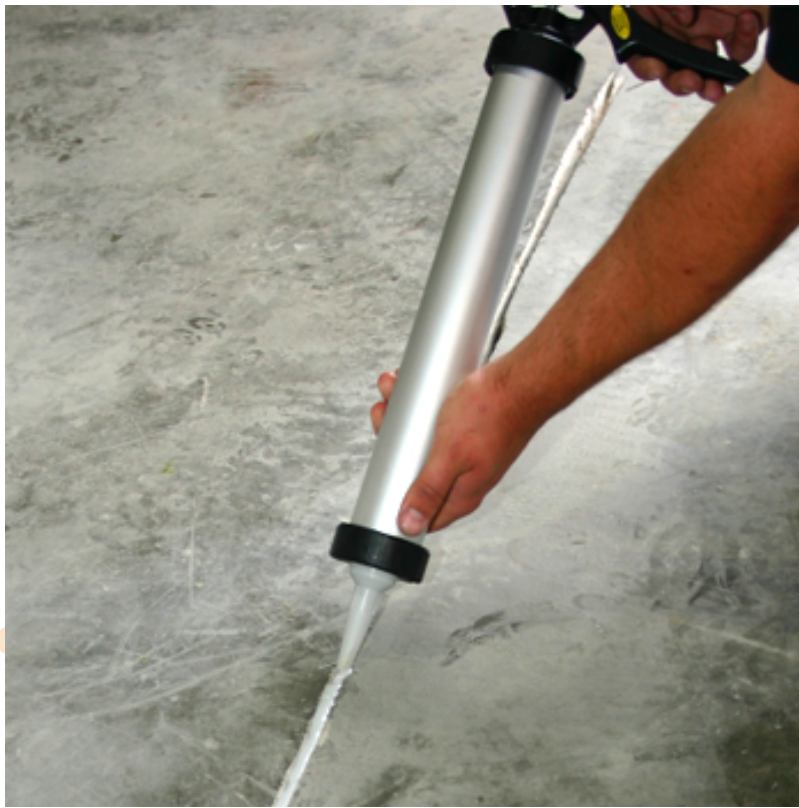
Foto: Aanbrengen voegmassa.
